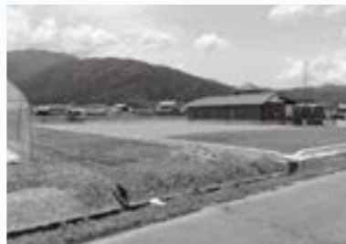
道の駅 禅の里拡張工事
