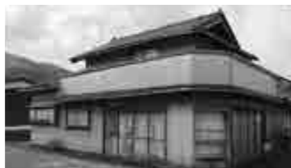
町内の空き家
