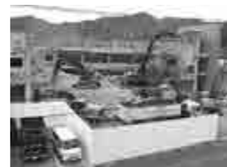
取り壊し中の上志比支所
