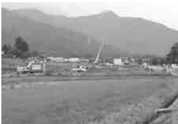
工事が進む永の里（西エリア）
