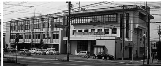
第1期公共施設再編計画で元消防本部は現東庁舎へ用途変更(写真右側)
