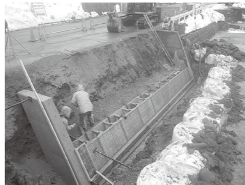
災害復旧工事作業現場
