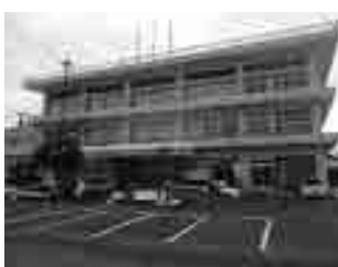
取り壊し間近の上志比支所
