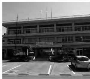
取り壊し計画の上志比支所
