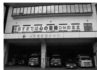
移転する松岡の消防庁舎
