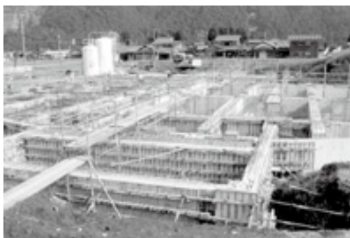
建設中の健康福祉施設
