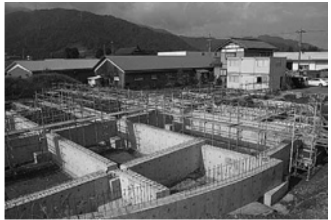
建設中の健康福祉施設
