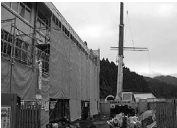
耐震工事中の志比南小学校
