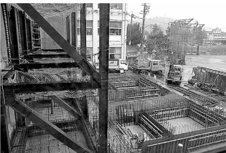
▲松岡中学校 耐震工事現場
