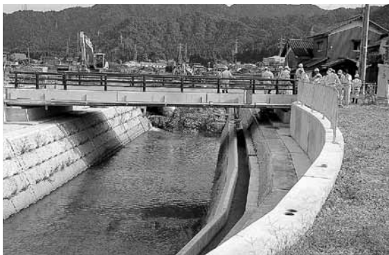
▶河内川護岸工事
