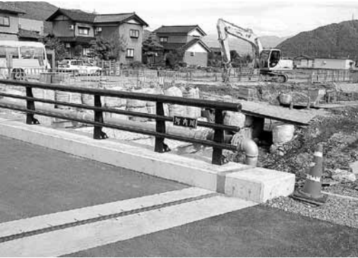
河内川護岸工事
