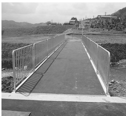
平成20年架替の上浄法寺 的川2号橋
