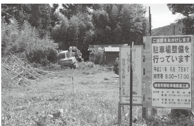
観音町駅パークアンドライド工事現場
