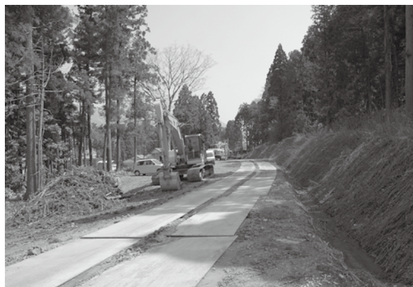
機能補償道路工事現場
