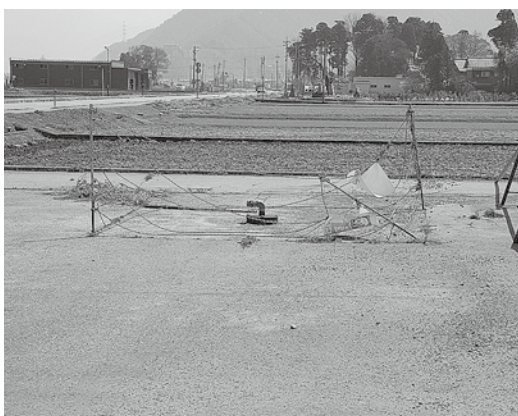
永平寺温泉掘削現場
