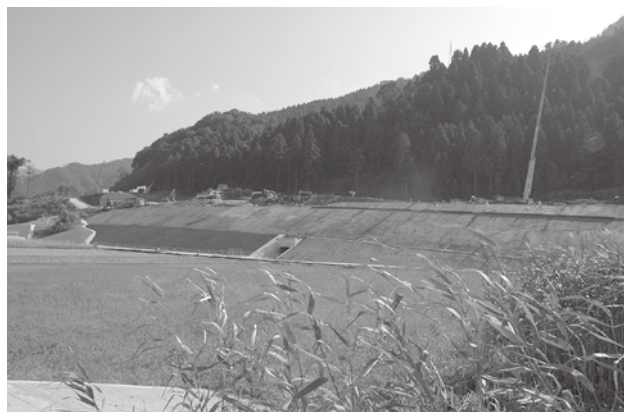
工事が進む中部縦貫自動車道
