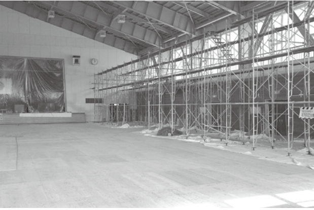
耐震工事中の永平寺中学校体育館
